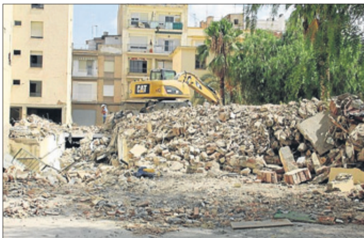
Derribo del viejo cuartel, en el verano del año 2011. JUAN CABALLERO
