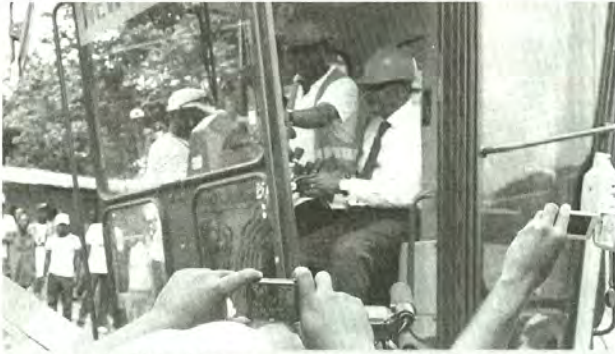
Le ministre délégué à l'Équipement, Jean Richard Sylong, lançant les travaux de réhabilitation de la route Popa/Koula-Moutou.
