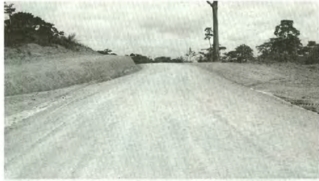
Une vue de la route Popa/Koula-Moutou. L'entreprise adjudicataire a commencé les travaux avant le lancement officiel.
