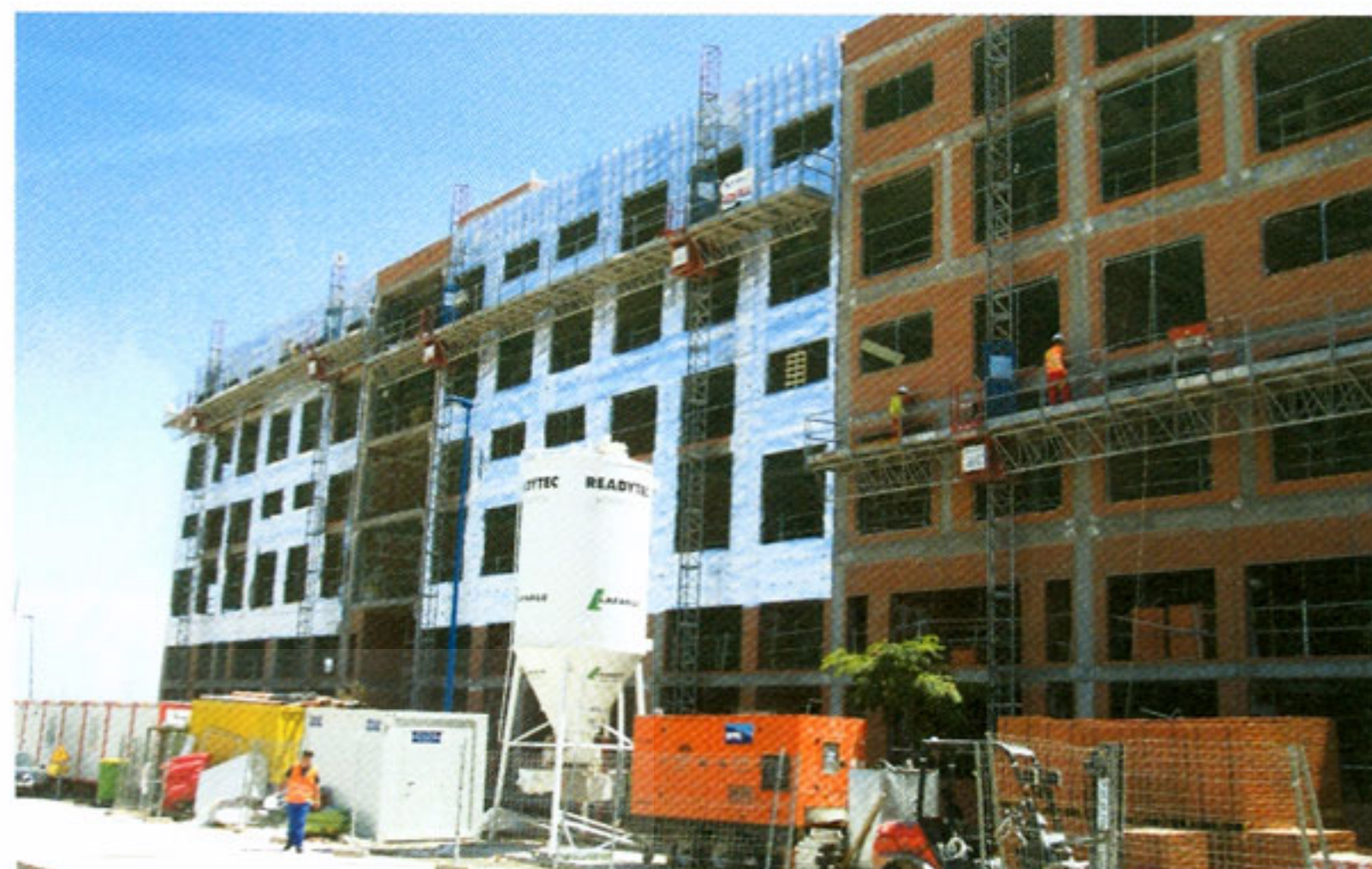
Optimer System ha participado en la creación de este edificio de nueva generación con la instalación de su aislamiento térmico reflectivo SuperPolynum HR
